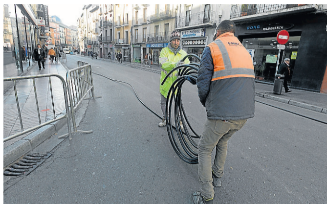
Operarios hicieron ayer acopio de materiales en el Coso. R. G.
