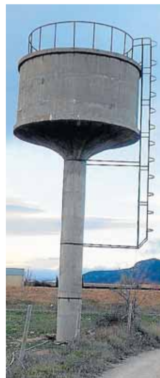
Depósito de agua de Apiés.
