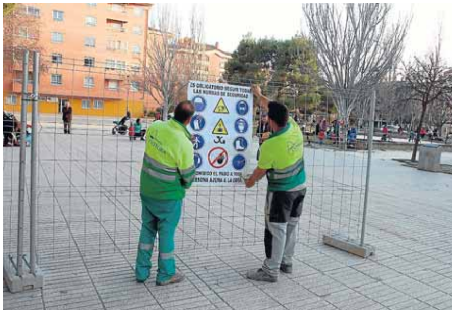
Operarios de la empresa vallaron ayer el recinto donde se va a intervenir.
