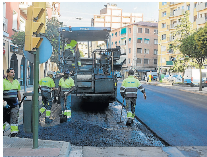
Trabajos de asfaltado ayer en la avenida La Paz. RAFAEL GOBANTES
