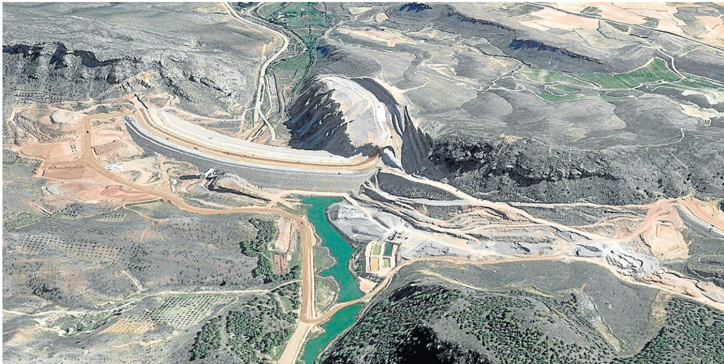
Imagen aérea del embalse de Mularroya en construcción, en el que se aprecia el cuerpo de la presa. GOOGLE MAPS
