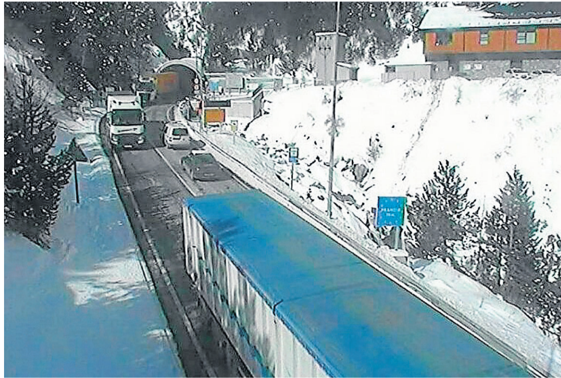
CONSORCIO DEL TÚNEL BIELSA-ARAGNOUET
