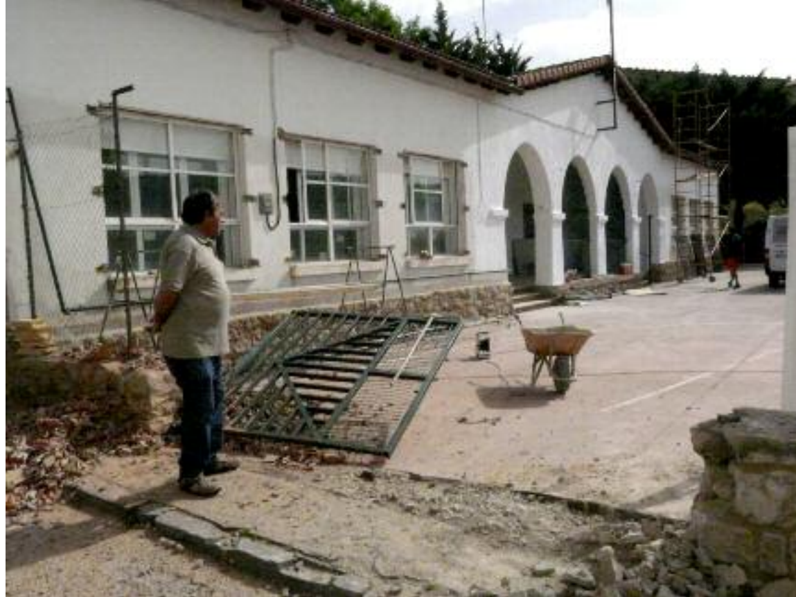
Obras de mejora que se están acometiendo en la escuela de Guadalaviar donde se invierten 68.000 euros del Fite
